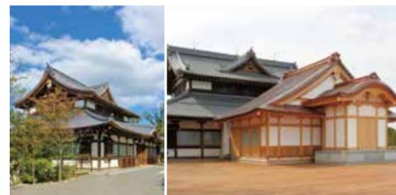
解体した1000点もの部材を大型トラック6台で掛川の弊社工場に運び、痛んだ箇所を修繕。すかさず京都に戻し、大工職人25人で1年かけて移築しました。次の100年につなぐ大役を終えたのは、2014年10月でした。現在、国宝「青不動明王二童子像」などが安置され、京都の新しい観光名所として注目を集めています。
